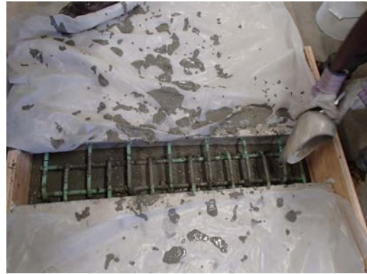
(b) Closure pour casting
